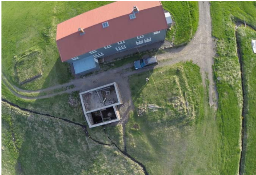
Smiðjugrunnur sést hér hægra megin við vatnhús 048 sem er með uppistandandi veggjum en þaklaust
