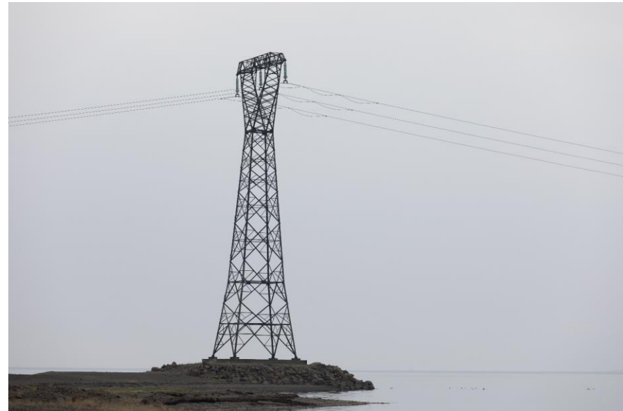
Mynd 14-1 Háspennumastur í Gilsfirði.
