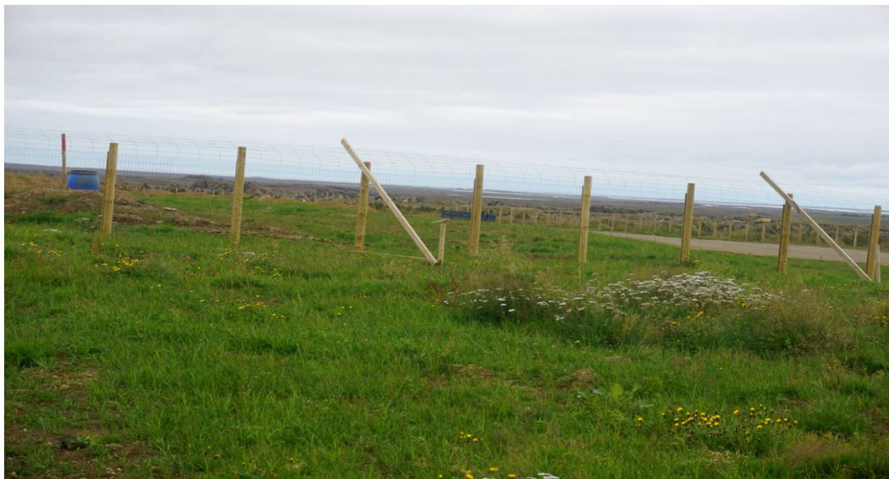
Mynd 7. Fokvarnargirðing sem sett var upp við urðunarstaðinn 2020.
