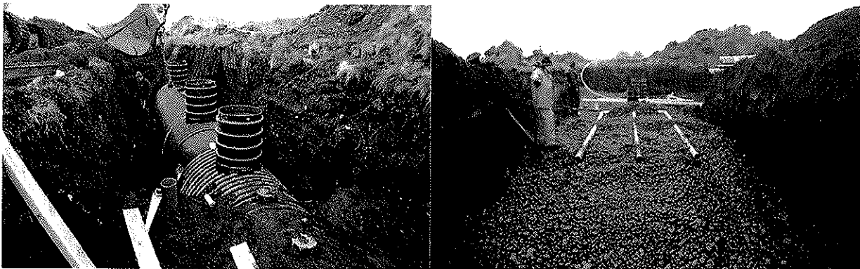
Framkvæmdir við nýtt fráveitumannvirki, rotþró og siturlögn.
