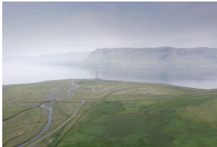
Mynd 14-3 Geiradalslína 1 liggur yfir Gilsfjörð og fæðir Vestfirði.
