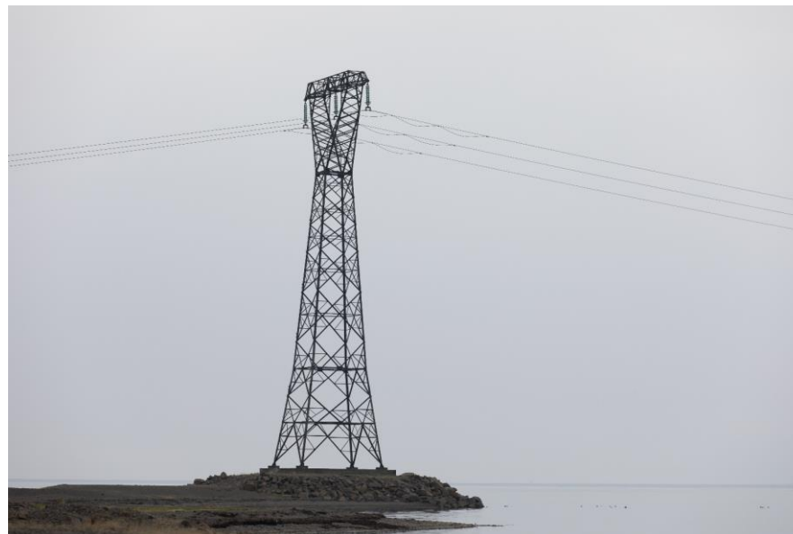
Mynd 14-1 Háspennumastur í Gilsfirði.
