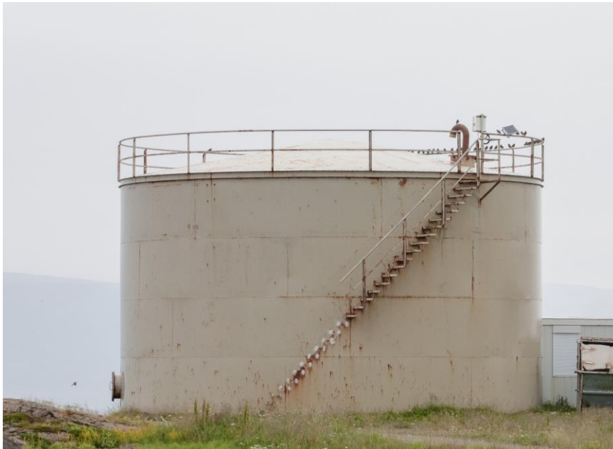
Mynd 14-2 Vatnsveita í Búðardal.
