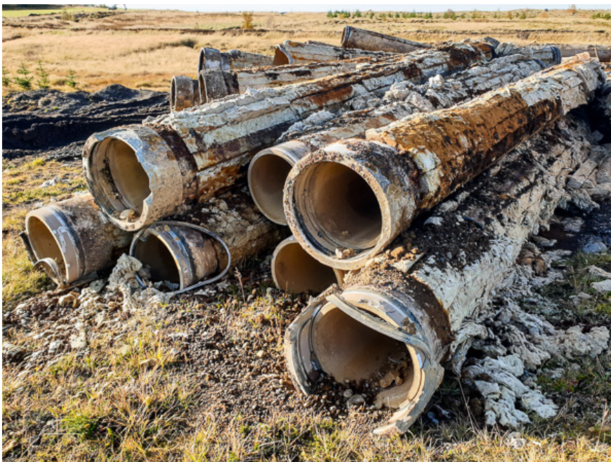
3. mynd. Tímabundið starfsleyfi var veitt til að fjarlægja gamlar vatnslagnir með asbesti.
