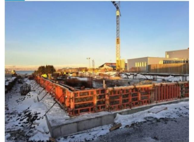
Uppsláttur sökkulvegja undir íþróttasalnum. Ljósmynd: dalir.is
