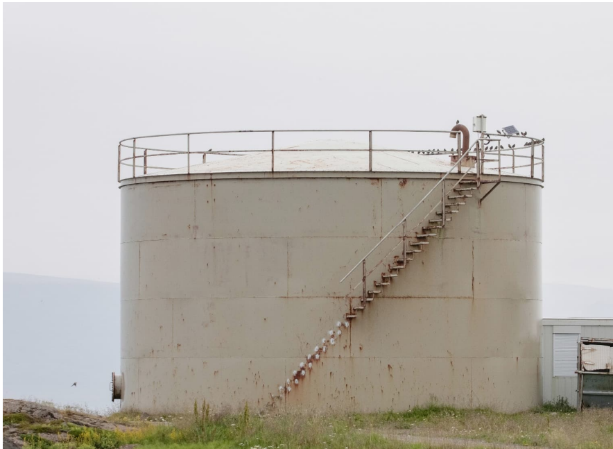
Mynd 14-2 Vatnsveita í Búðardal.
