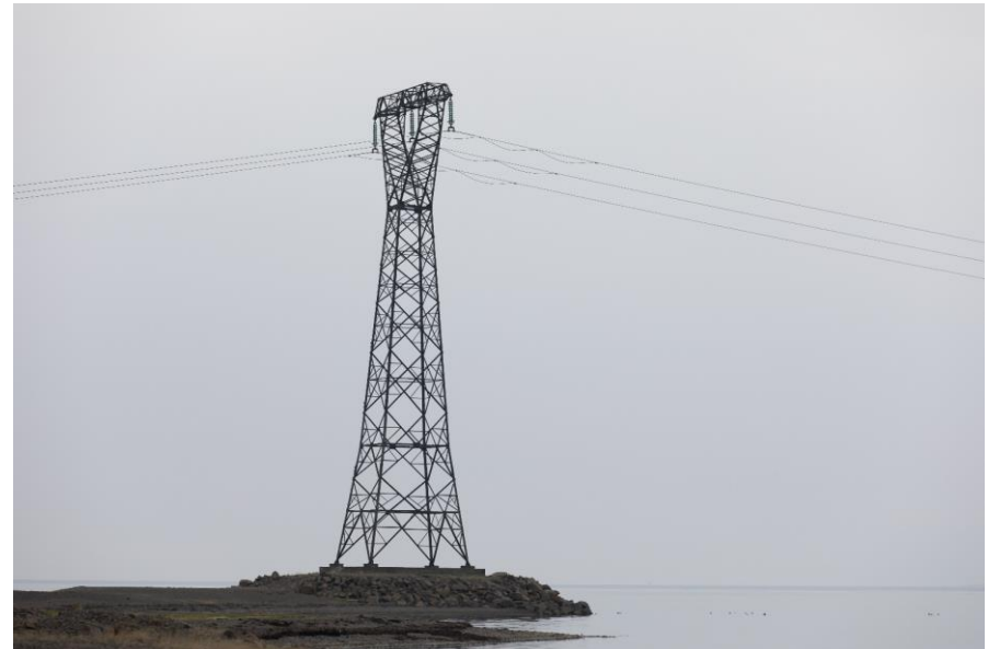
Mynd 14-1 Háspennumastur í Gilsfirði.
