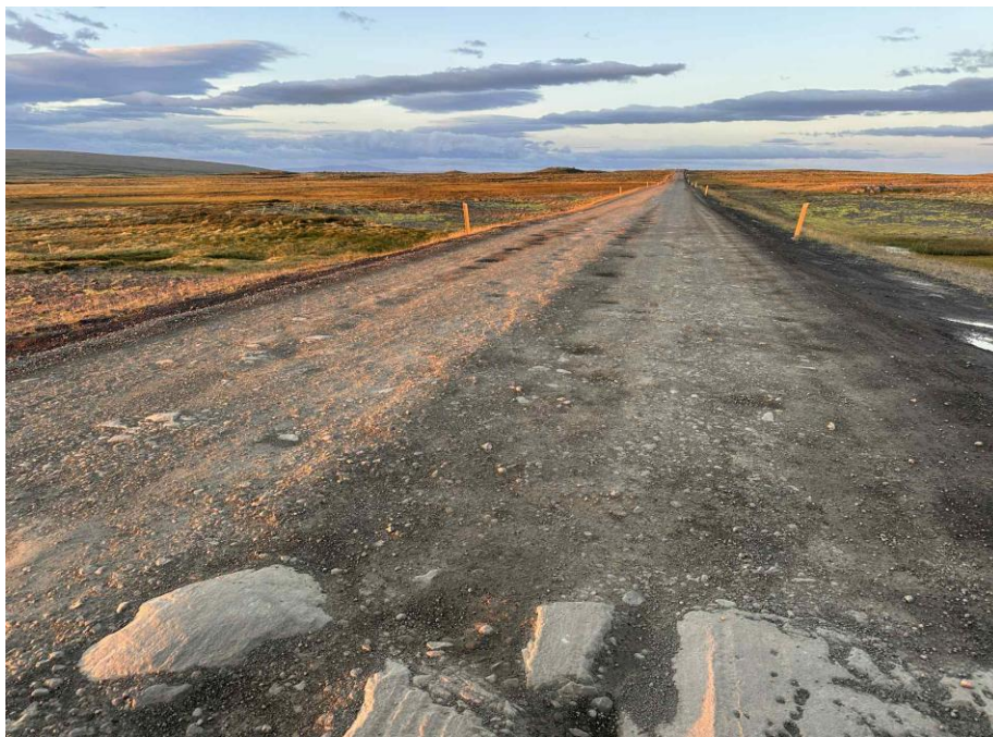
Mynd tekin á Laxárdalsheiði í ágúst 2025 á vegkaflanum sem enn er án slitlags. Klappir farnar að standa upp úr veginum, hryggur farinn að myndast á miðjum vegi og holur víða.
