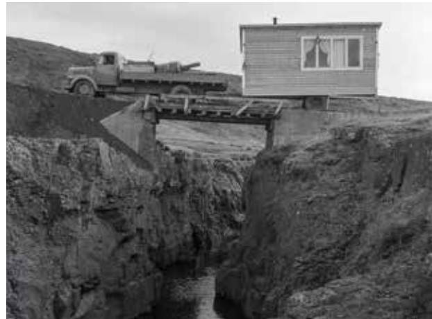
Vegavinnuskúr fluttur yfir nýbyggða brúna á Skraumu í Hörðudal 1958. Skrauma var fyrst brúuð 1892 af nokkrum bændum í Hörðudal. Ný brú tók við þessari brú 2023. Ljós. Lárus Magnússon í Tjaldanesi. Byggðasafn Dalamanna.
