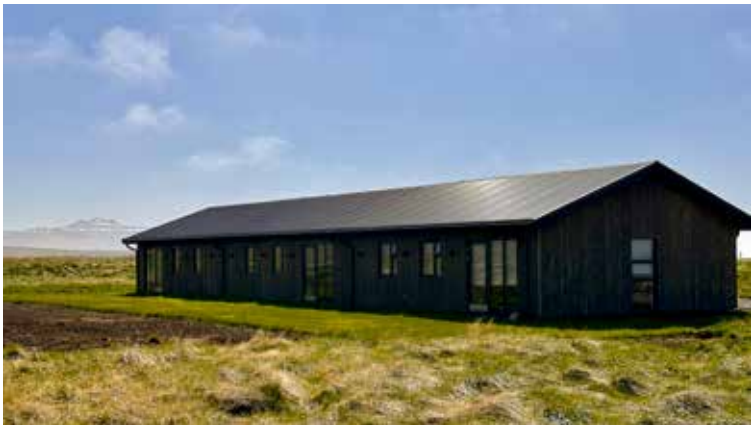
Dalasmíði byggði þrjár hagkvæmar leiguíbúðir í Búðardal fyrir Bakkahvamm hses. sem voru teknar í notkun 2023.
