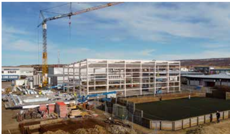
Íþróttahúsið í byggingu.
